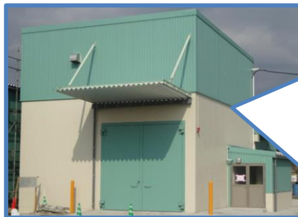
非破壊検査棟
